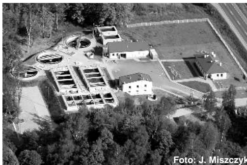
Gminna oczyszczalnia cieków w Przyszowicach
