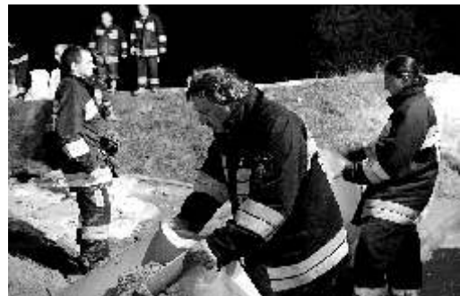
12 czerwca br. (2.00 w nocy) strażacy z gminnych jednostek OSP umacniają wał przy ul. Brzeg w Przyszowicach.
